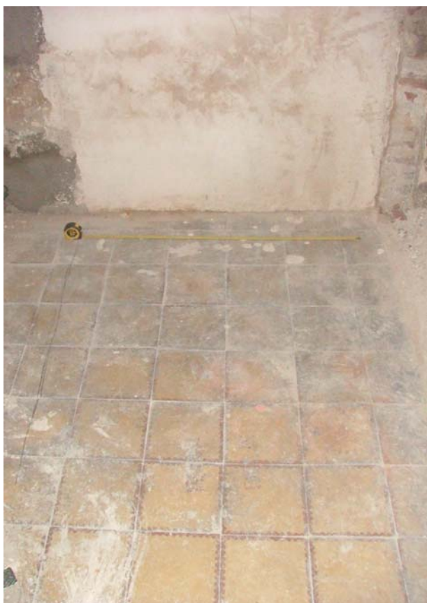
Foto 1 : Demolició de l'envà UE 015
